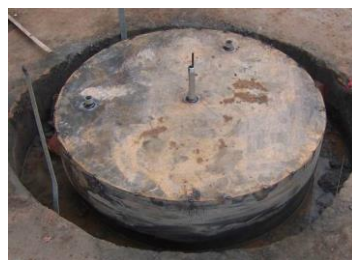
(d) 侧护板与盖板安装
